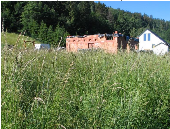
Foto 6: Pohled na plochu Z5 od severovýchodu.
